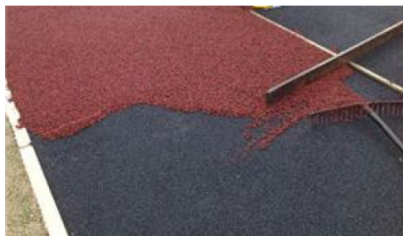
Figura 7. Esempi di manto sintetico elastico posato in opera
