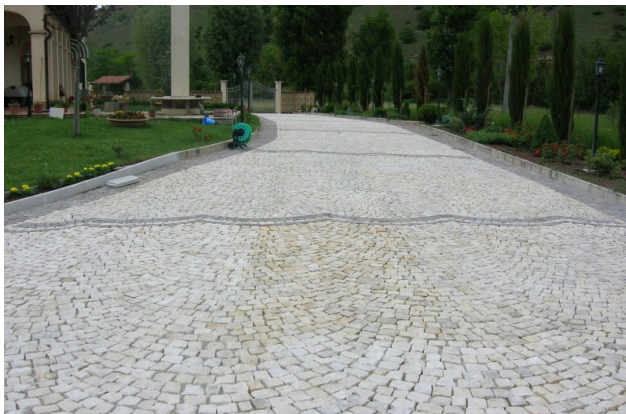
Figura 4. Esempio pavimento in cubetti di porfido
